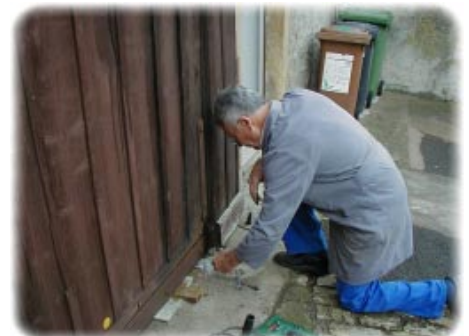
...und Paul reparierte das große Eingangstor unseres Clublagers.
